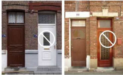
À gauche, la porte d'origine en bois peint ; à droite, une porte neuve standard, différente de forme, matériau et couleur.
