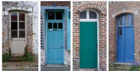
Porte vitrée, début XX e siècle / Porte d'entrée, début XX e siècle / Portes contemporaines en bois, avec impostes vitrés /
